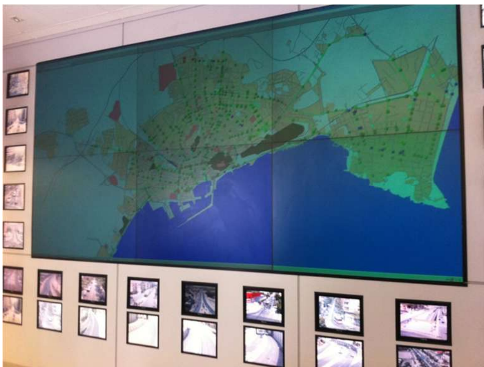
Imagem 38 Centro de Controle do tráfego de Alicante. Espanha
