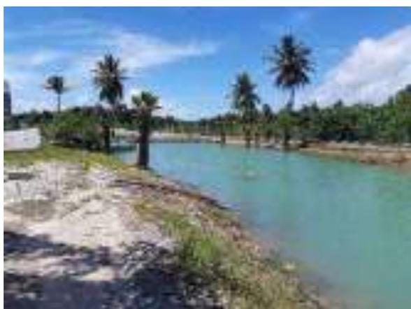
Figura 73: Exemplo de lagoa pluvial criada para retenção das águas do Campus da Fiocruz no Eusébio. Foto: Architectus.
