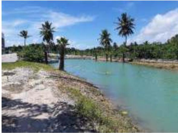
**Figura 46:** Exemplo de lagoa pluvial criada para retenção das águas do Campus da Fiocruz no Eusébio. Foto: Architectus.
