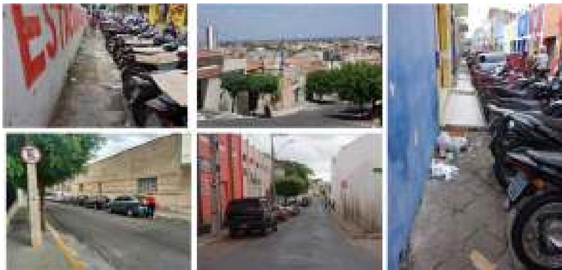
Imagem 2 - Calçadas sem condições ótimas
