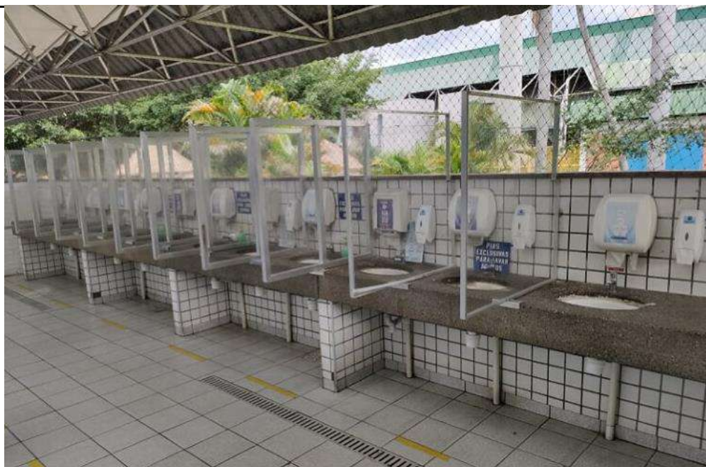
PIAS DOS REFEITÓRIOS DOTADAS DE BARREIRAS DE PROTEÇÃO HIGIENIZAVEIS
