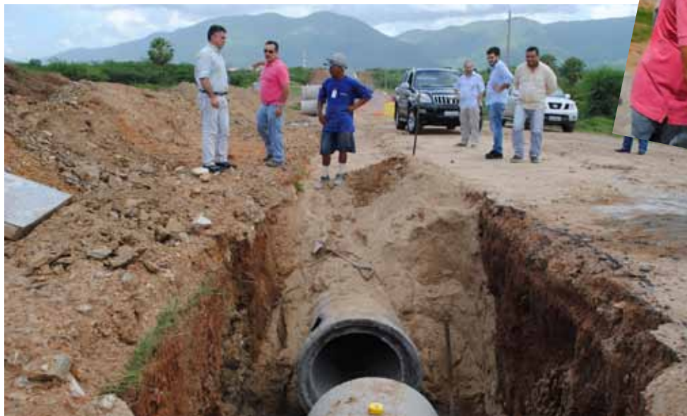
Obras de duplicação da Avenida Cleto Ferreira da Ponte
