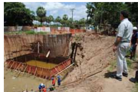
Construção da Lagoa de Estabilização do Novo Recanto
