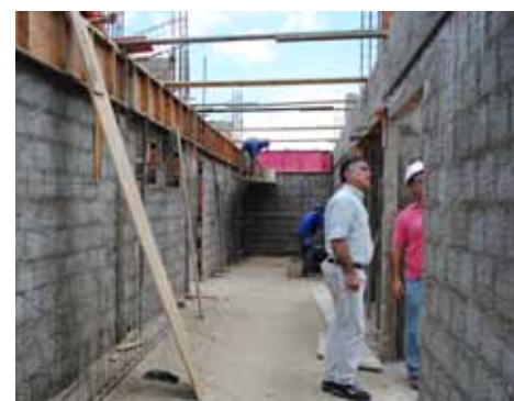
Futuras instalações do Centro de Educação Infantil no Novo Recanto
