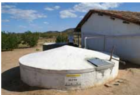
Cisternas de placa vão ser instaladas em 35 municípios
