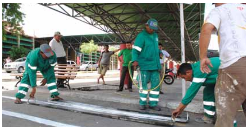
A sinalização foi refeita em frente a rodoviária.
