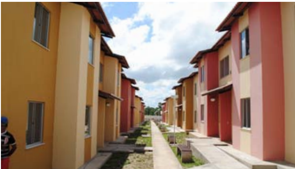
Unidades habitacionais no Residencial Jatobá I, no Bairro Sinhá Sabóia.
