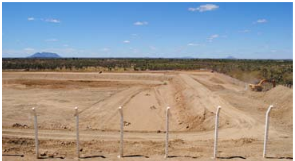
Estação de Tratamento de Esgoto dos Remédios
