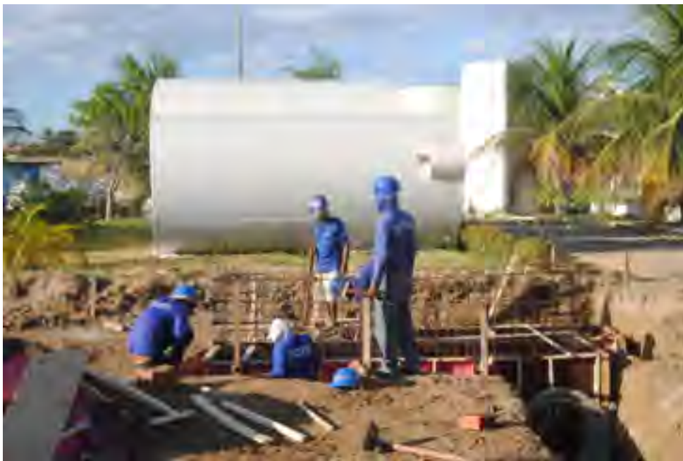
Equipes do SAAE trabalham na instalação dos módulos na ETA do Sumaré
