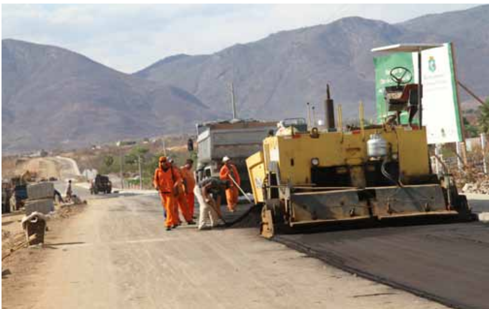
Obras de pavimentação na Avenida Cleto Ponte
