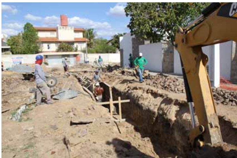
Equipes da Prefeitura realizam trabalho de drenagem no Bairro Colina
