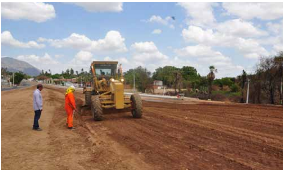
Obras na Avenida José Euclides
