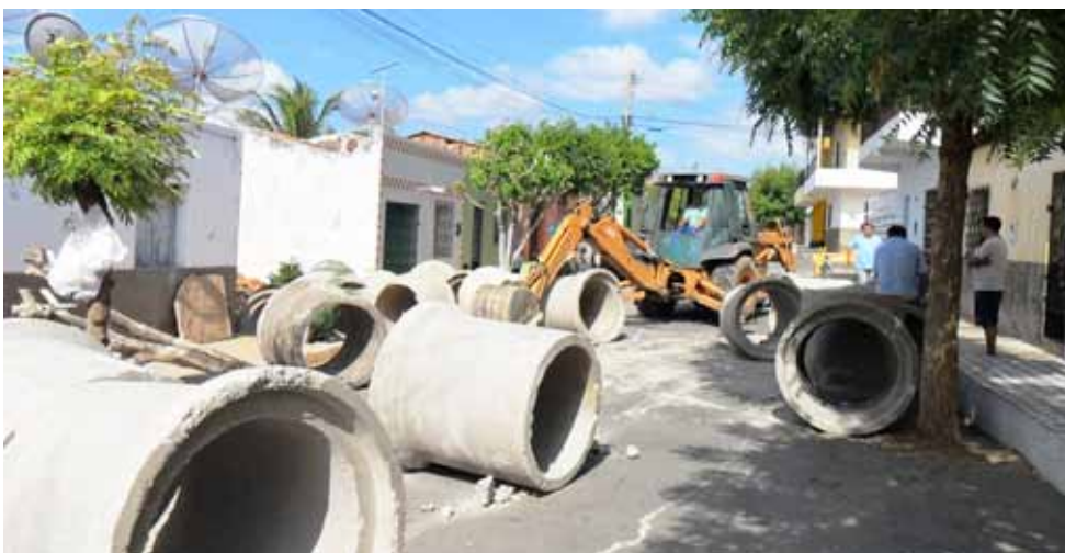
Obras de drenagem na rua Nazaré Pereira, no Distrito de Taperuaba.
