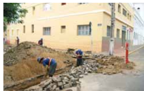
Obras na rua Dr. Monte ao lado da Pça. São João
