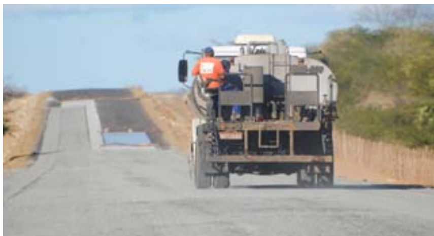
Trecho da nova CE 240 começa a ser asfaltado
