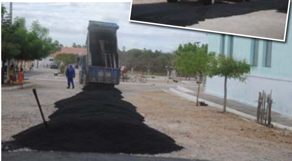
No Distrito de Bonfim o asfaltamento das ruas foi concluído na sexta-feira, 13 de julho.
