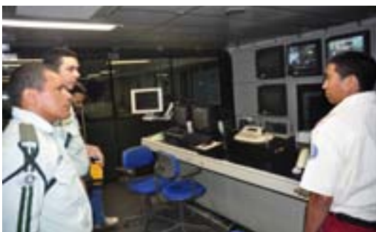
Central de Videomonitoramento
