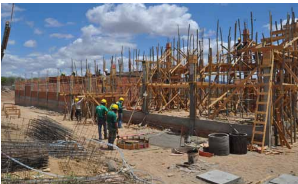
Obras da Escola de Tempo Integral, em Aracatiçu.
