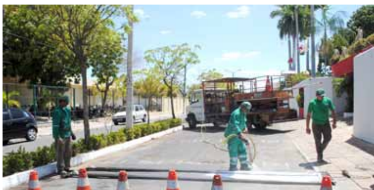
Sinalização de trânsito está sendo renovada em ruas e avenidas
