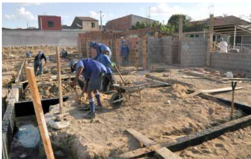
Obras do Centro de Saúde da Família no bairro Cohab II seguem em ritmo acelerado
