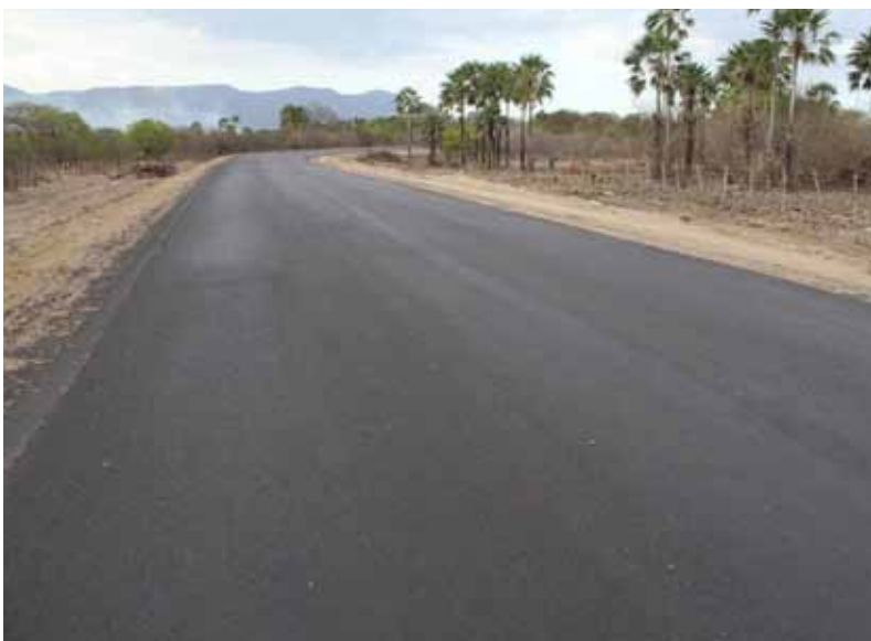
Trecho da nova estrada do Bomfim, já pavimentada com asfalto.
