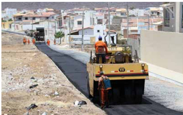
Asfaltamento em ruas do bairro Renato Parente
