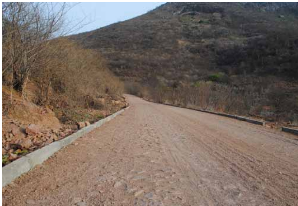
Trecho da estrada do Distrito de Baracho, que está sendo recuperada pela Prefeitura.
