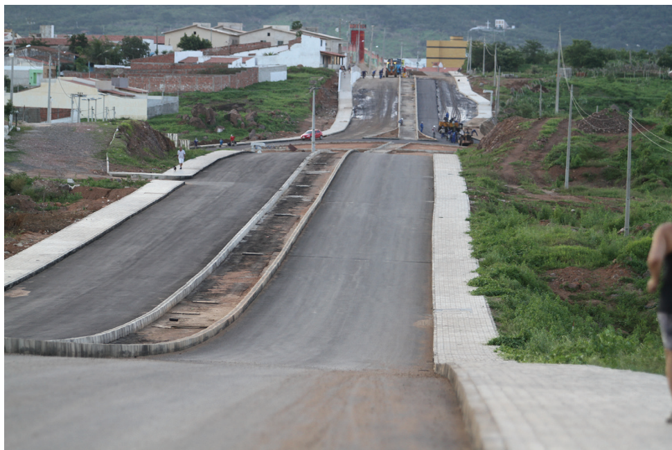
Avenida está com 75% das obras concluídas. O próximo passo será sinalização e iluminação
