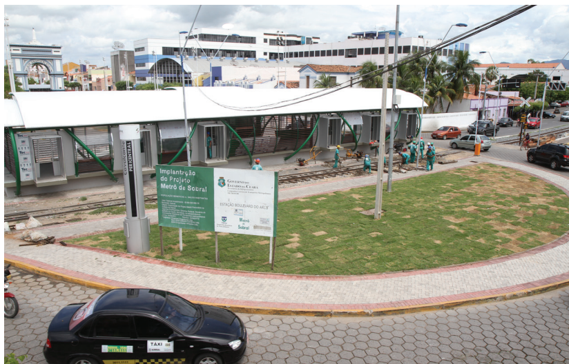
Interdição é necessária para continuidade das obras do VLT de Sobral
