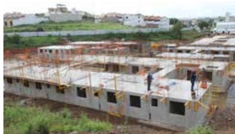
Estão sendo construídas 2.084 unidades habitacionais, no bairro Cidade José Euclides
