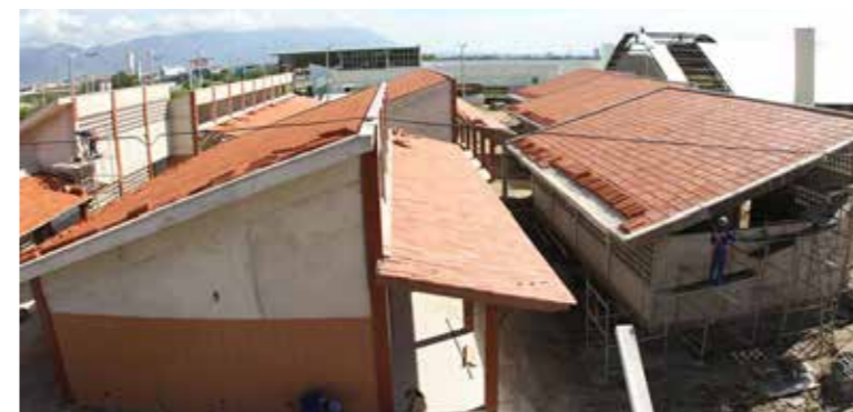
CEI do Conjunto Santa Clara está com 80% das obras concluídas
