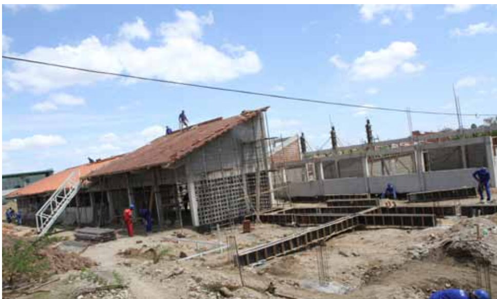
Obras da Escola de Tempo Integral no Conjunto Santa Clara.
