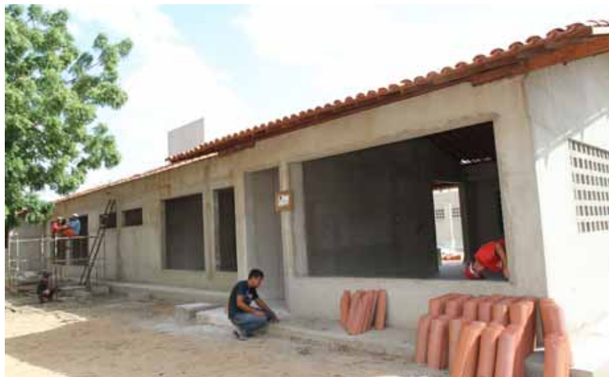
Obras do Centro de Educação Infantil do Bairro Santa Casa
