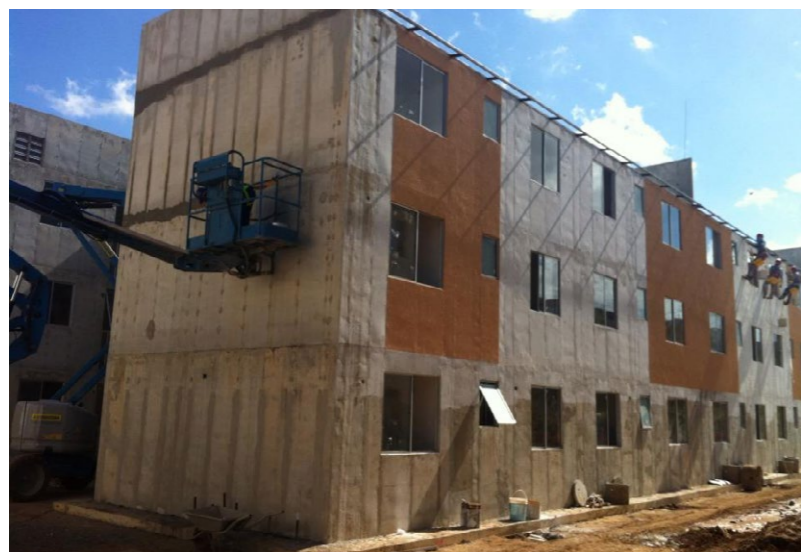
Previsão de conclusão das obras é julho de 2014. Já foram construídos 470 apartamentos
