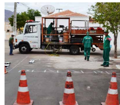
Estão sendo instalados redutores de velocidade e faixa de pedestre em locais com maior concentração de pessoas
