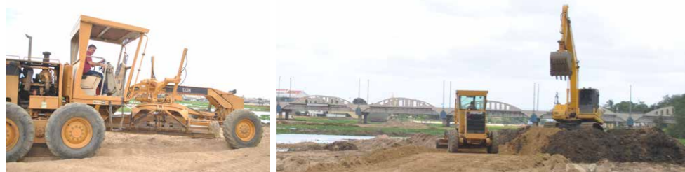
Prefeito Veveu vistoria obra de limpeza do Rio Acaraú, que deve ser concluída em 40 dias
