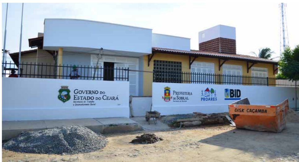
Construção do CRAS, no Alto da Brasília.
