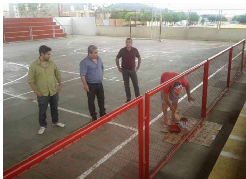
Obras na Quadra Poliesportiva no Distrito de Aracatiaçu já estão em fase final.
