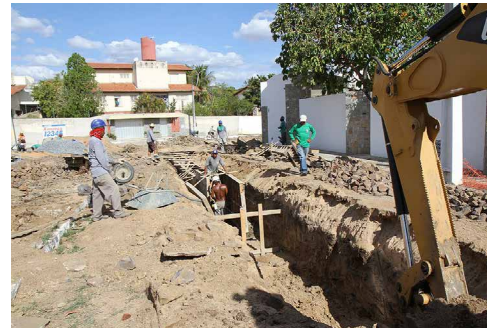
Obras de Saneamento realizadas em vários bairros de Sobral
