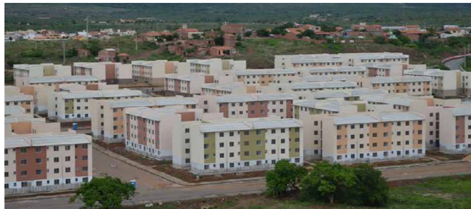
Unidades habitacionais em construção no bairro Cidade José Euclides
