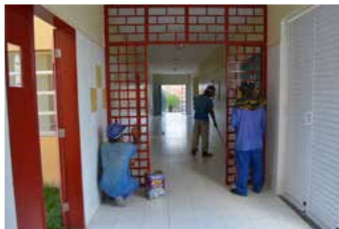
Obras nos CEI's estão em fase de conclusão
