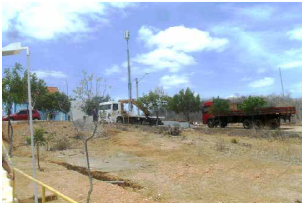
A antena da operadora de telefonia foi instalada ao lado da Capela da Mãe Rainha, em Taperuaba.
