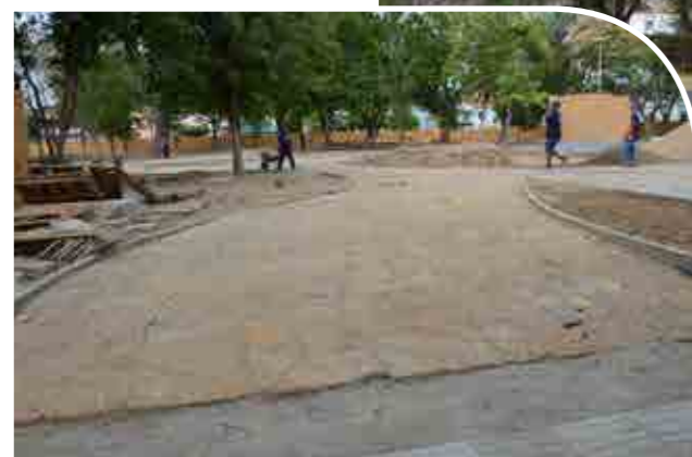
Obras de requalificação da Praça do Bosque
